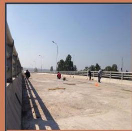
CẦU TRÀ LONG - BÌNH THUẬN Mặt sàn cầu KL: 1.200 M 2 - TC: 2015
