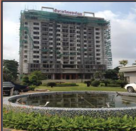
VIMEAN CHOYNAY CONDO - PHNOMPENH Hệ thống sê nô/ ban công/ khu nhà WC/ lô gia xử lý INCONSEAL.31 năm 2014
