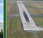
ĐƯỜNG BĂNG SÂN BAY
