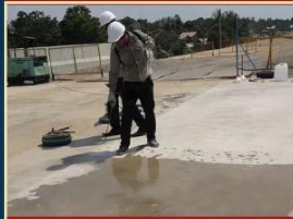
Phun nước bảo dưỡng
