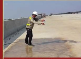
Bảo dưỡng nước & làm sạch INCONSEAL.31 dư trên bề mặt
