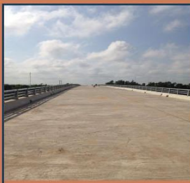
CẦU AN QUY - BẾN TRE Mặt sàn cầu KL: 3.000 M 2 - TC: 2015
