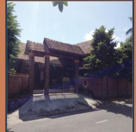
NHÀ TỬ ĐƯỜNG HỘ ĐÓ TRIỆU - KONTUM Mái ngói/ sê nô/ sân thượng/ khu vệ sinh được xử lý INCONSEAL.31 năm 2010
