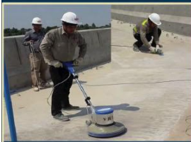
Vệ sinh bê tông
